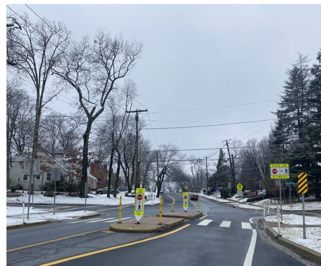
Pedestrian Refuge / Refugios en los Cruces Peatonales
