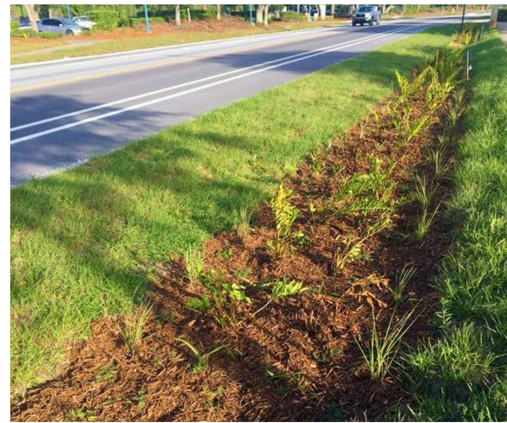
Bio-swales / Canal de Drenaje
