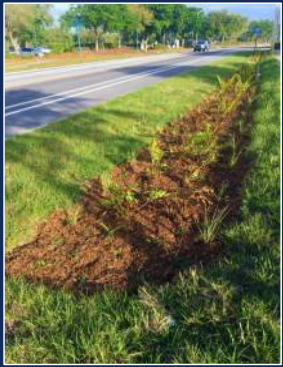
Canal de Drenaje
